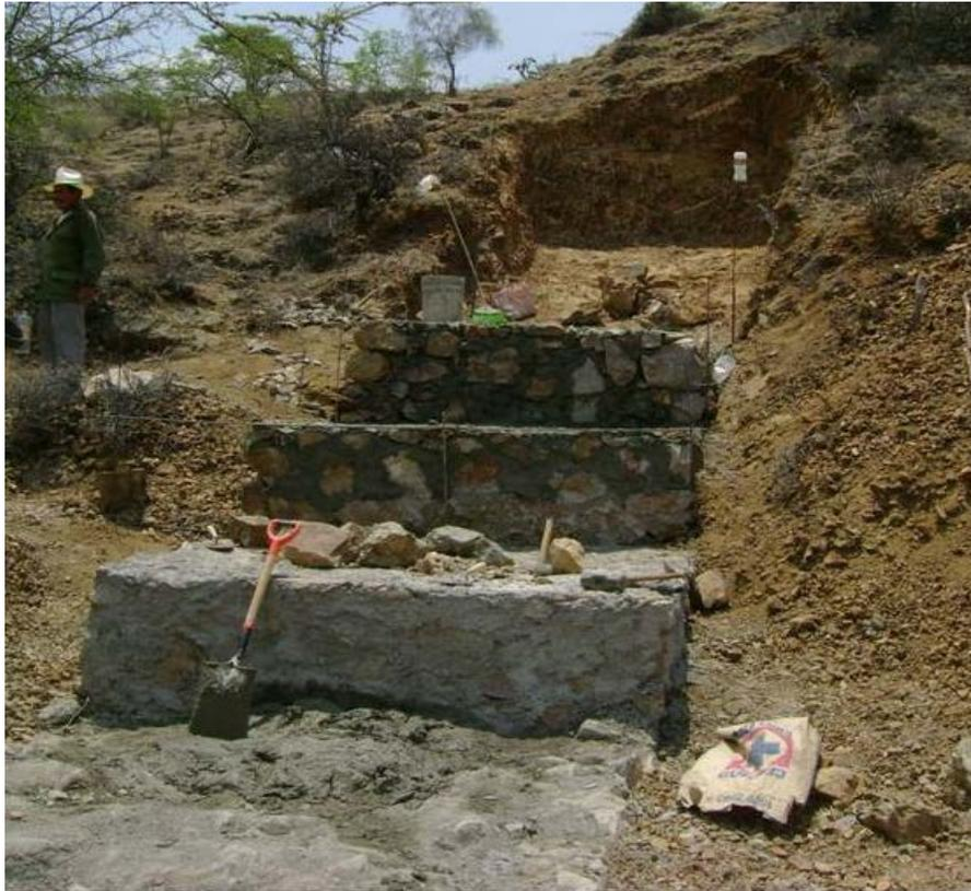
**Figura 3.** Nivelación con mampostería y en los extremos muros escalonados para la mejor transmisión de esfuerzos.
