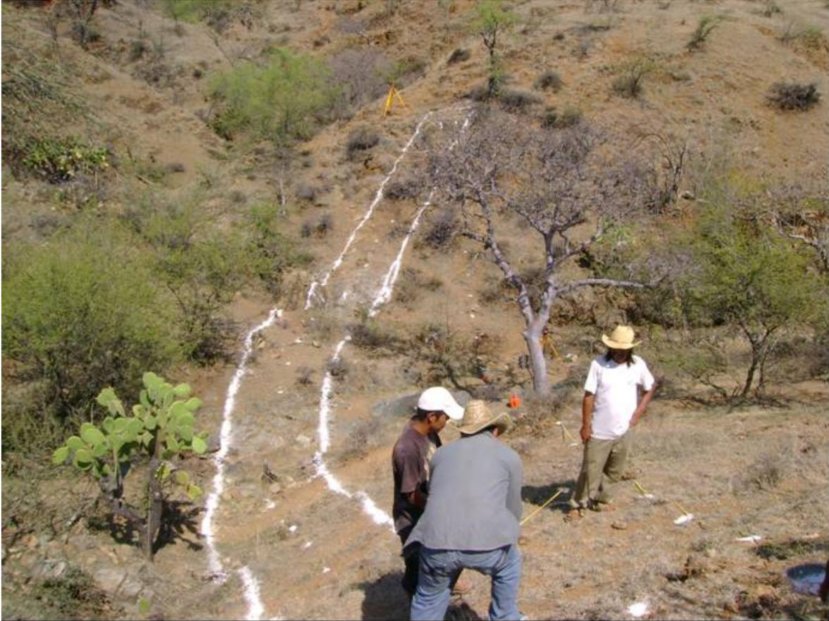
**Figura 2.** Trazo de la curvatura de la pantalla
