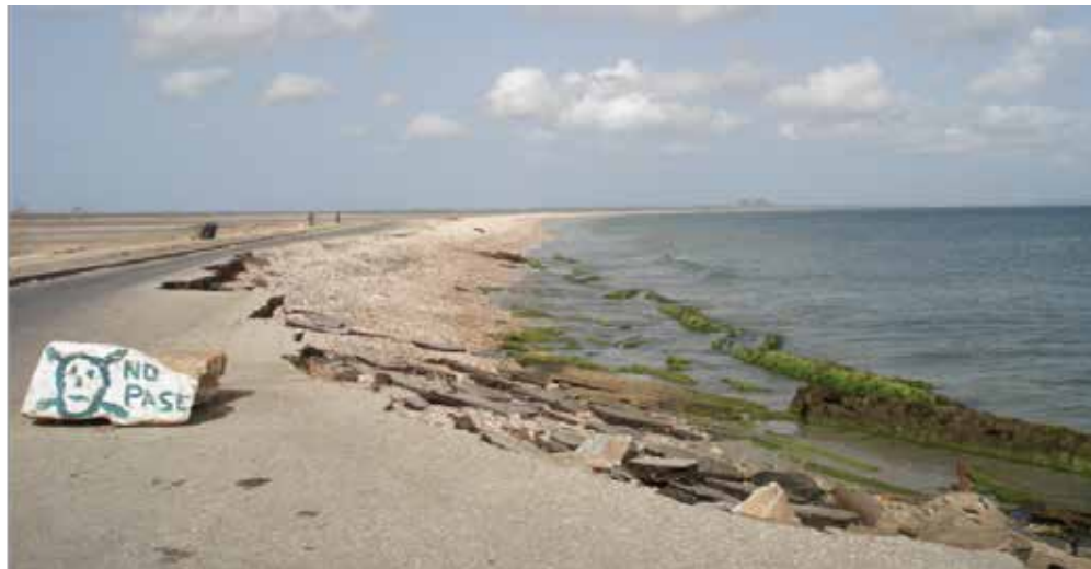
Figura 5. Situación de erosión en el extremo Este de La Restinga.
