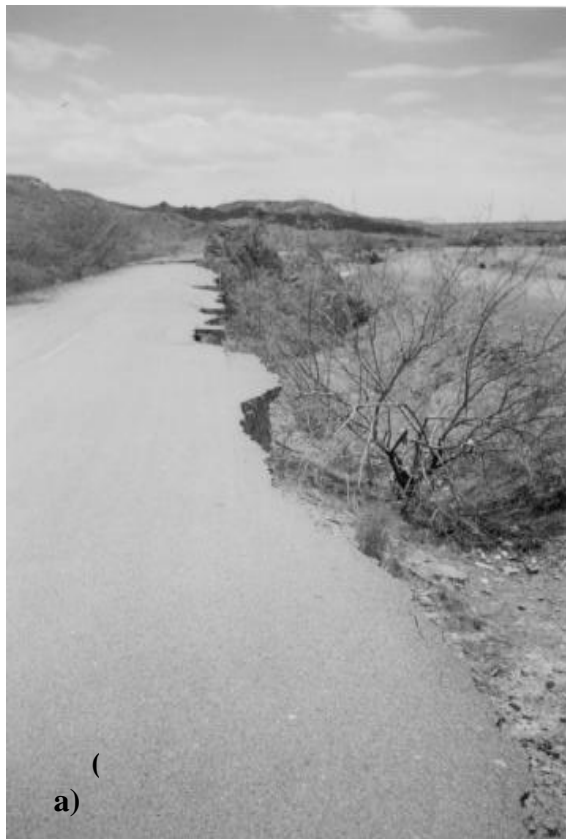
Figura 6. Restos de terraplén y pavimento de la carretera Panamericana Norte dañados por el agua.
