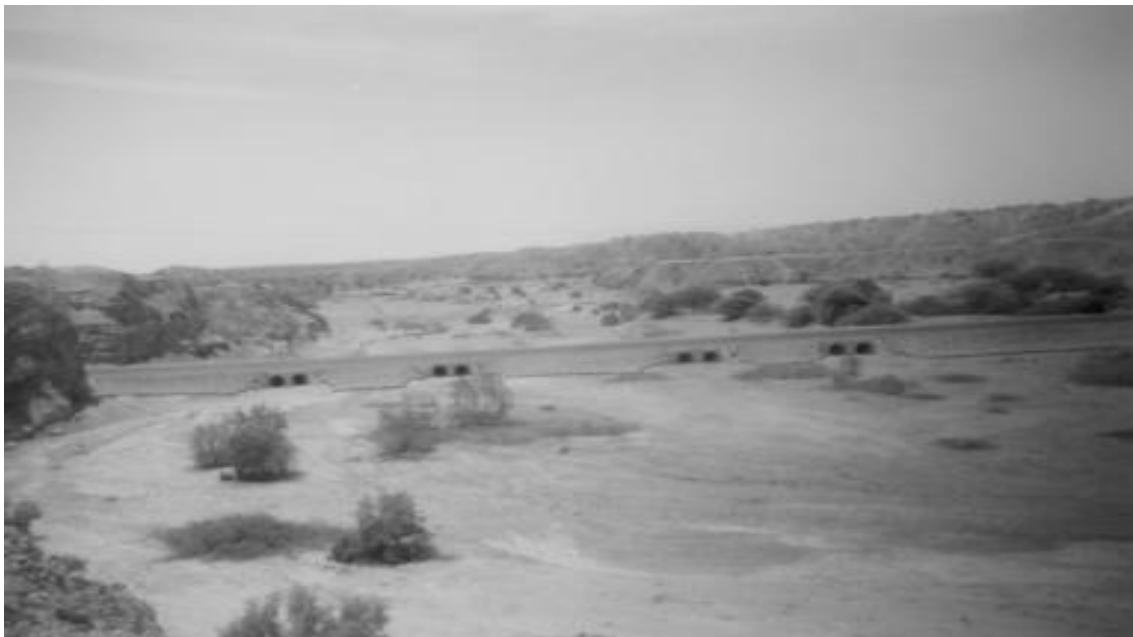
Figura 9. Tramo reconstruido de la carretera Panamericana Norte entre las ciudades Talara y Tumbes del Perú.
