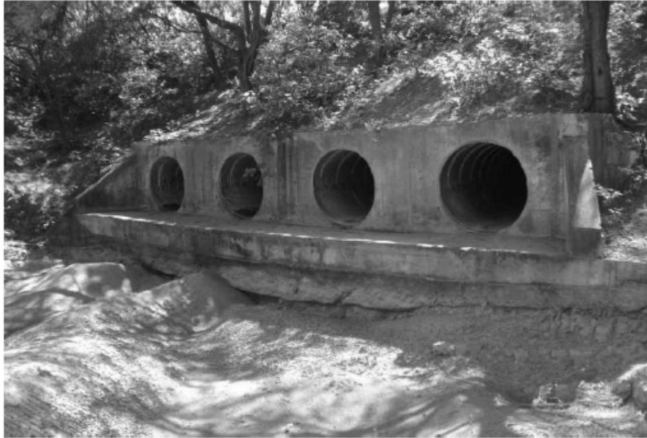
Figura 4. Daños más frecuentes a la salida de alcantarillas: son consecuencia de la erosión de fondo; no es difícil evitarlos con medidas relativamente simples.
