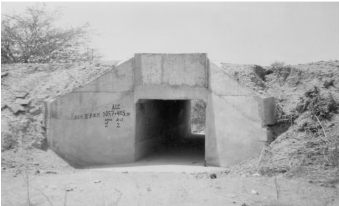
Figura 3. Daños del terraplén a la entrada de una alcantarilla: se nota que los aleros han sido sobre-elevados hasta el nivel máximo del orificio; aún así sería mucho mejor tenerlos nivelados con la altura del parapeto.
