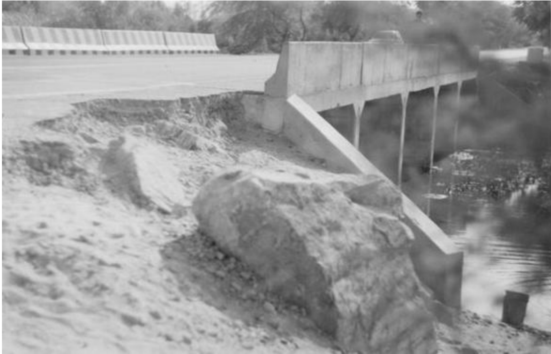
Figura 2. Huellas notorias del daño que amenazó con destruir el terraplén a la salida de la alcantarilla.
