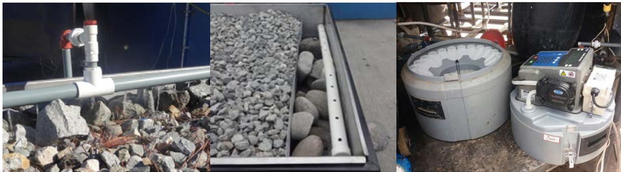
**Figura 3. Estructura de entrada, salida y equipo de muestreo automático**
