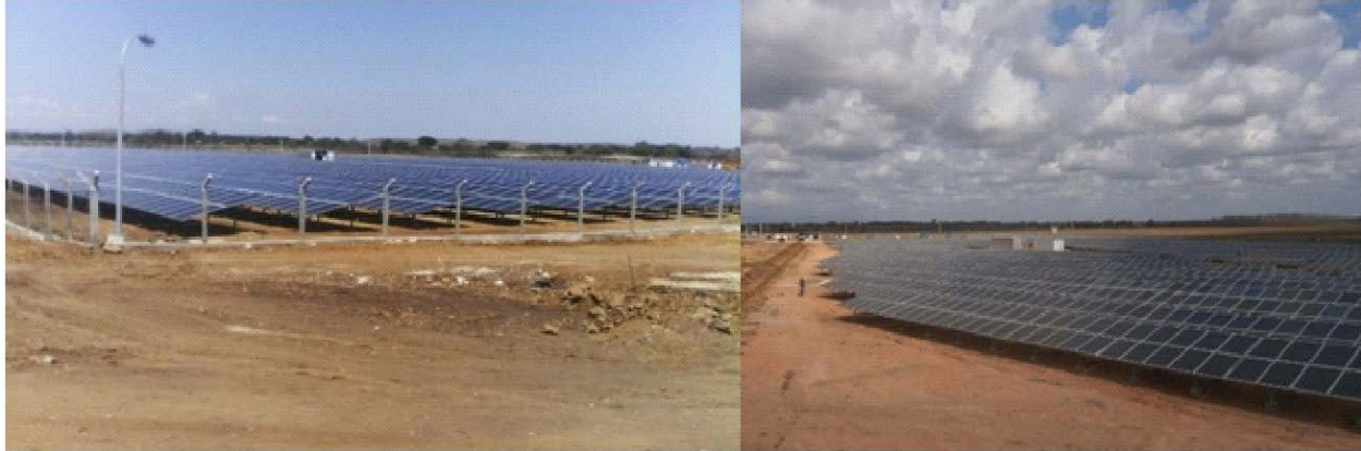
Figura 2. Ejemplo de parques fotovoltaicos construidos en Cuba
