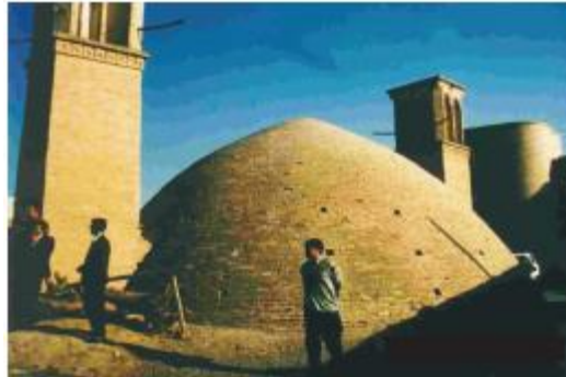
Figura 4. Abanbar, cisterna tradicional del pueblo de Isfahan, Irán [tomado de Gnadlinger (2015)]
