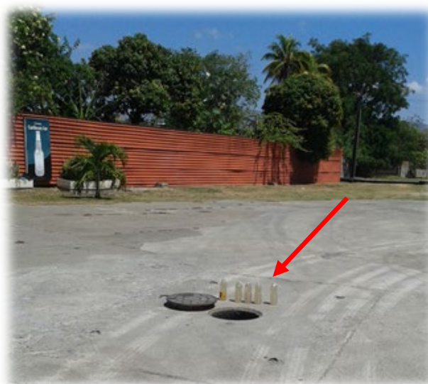
Figura 5. Registro del sistema de alcantarillado.
