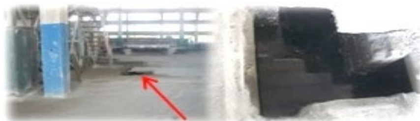
Figura 10. Descarga de los moldes de los paneles de prefabricado.
