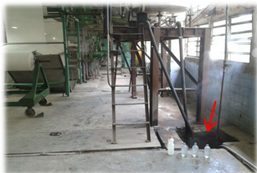
Figura 3. Registro del taller de acabado.
