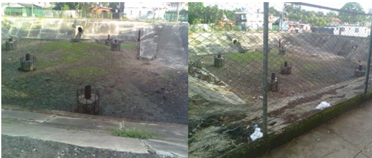
Figura 12 Pozos de recarga en la zona hundimiento desplome de una caverna.
