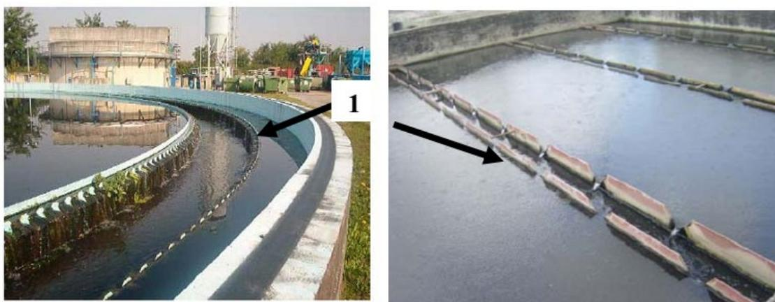
**Fig. 3.** – Descarga sobre el vertedor. Izquierda sedimentador circular. Derecha sedimentador rectangular.
