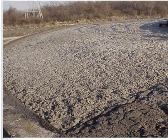
**Fig. 7.** – Espuma generada en la superficie de los sedimentadores secundarios debido a la presencia de organismos filamentosos.
