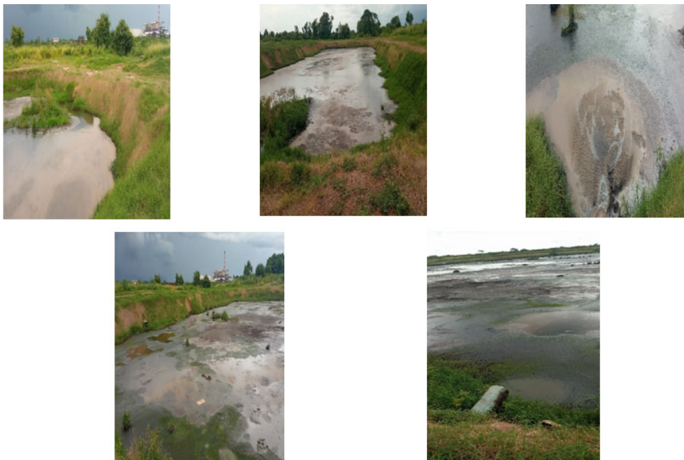
Fig. 14. - Estado actual de las lagunas de estabilización de la EEA
