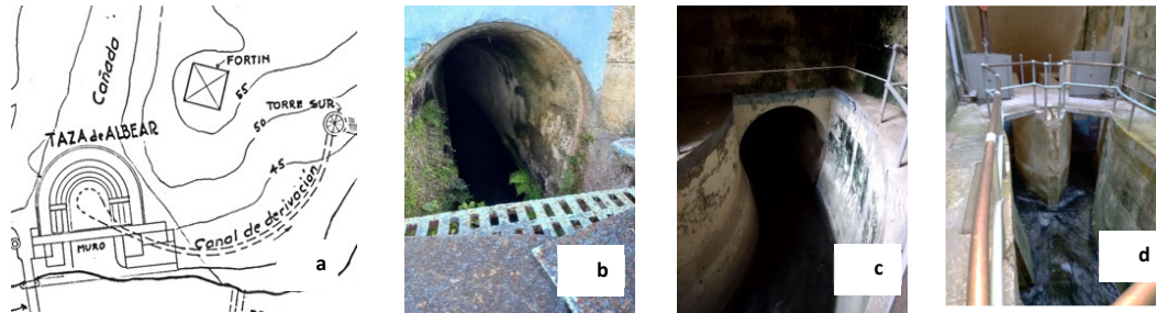
Figura 6. a) Vista en planta de canal de derivación Adaptado de Simón (1950b), b) entrada al canal de derivación desde Taza Grande, c) salida del canal de derivación en Torre Sur, d) tajamar.
