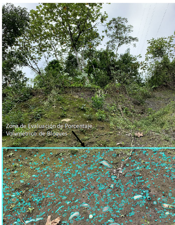
Figura 3. Talud evaluado de la vía de acceso al puente Copueno.
