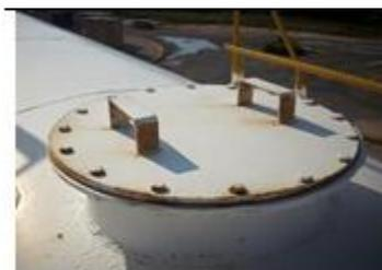
**Fig. 21** Boquilla de acceso al interior del tanque
