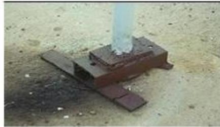
**Fig.2** Soportes de tuberías
