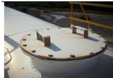
**Fig. 11** Boquilla de acceso al interior del tanque
