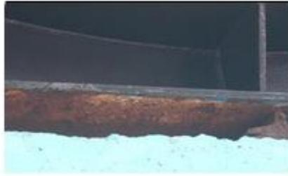
**Fig.1** Area inaccesible entre la base del tanque y la de hormigón
