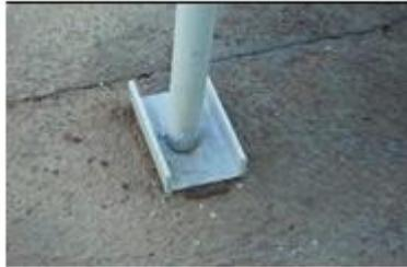
**Fig. 9** Problemas de retención de humedad, depósito y agua
