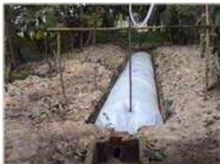
**Biodigestor de polietileno**
