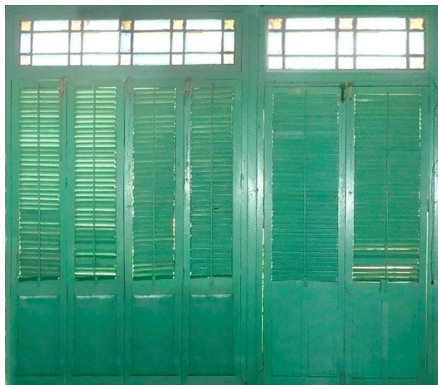
Figura 6. Cierre de la saleta al patio interior. Calle Cuba No. 55 Santa Clara. Año de construcción 1909.
