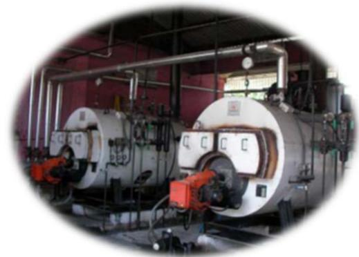
**Figura 2. Generador de vapor pirotubular.**
