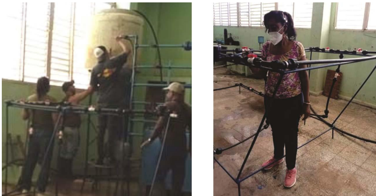
Fig.4: Vista parcial de la instalación hidráulica construida para las prácticas de laboratorio
