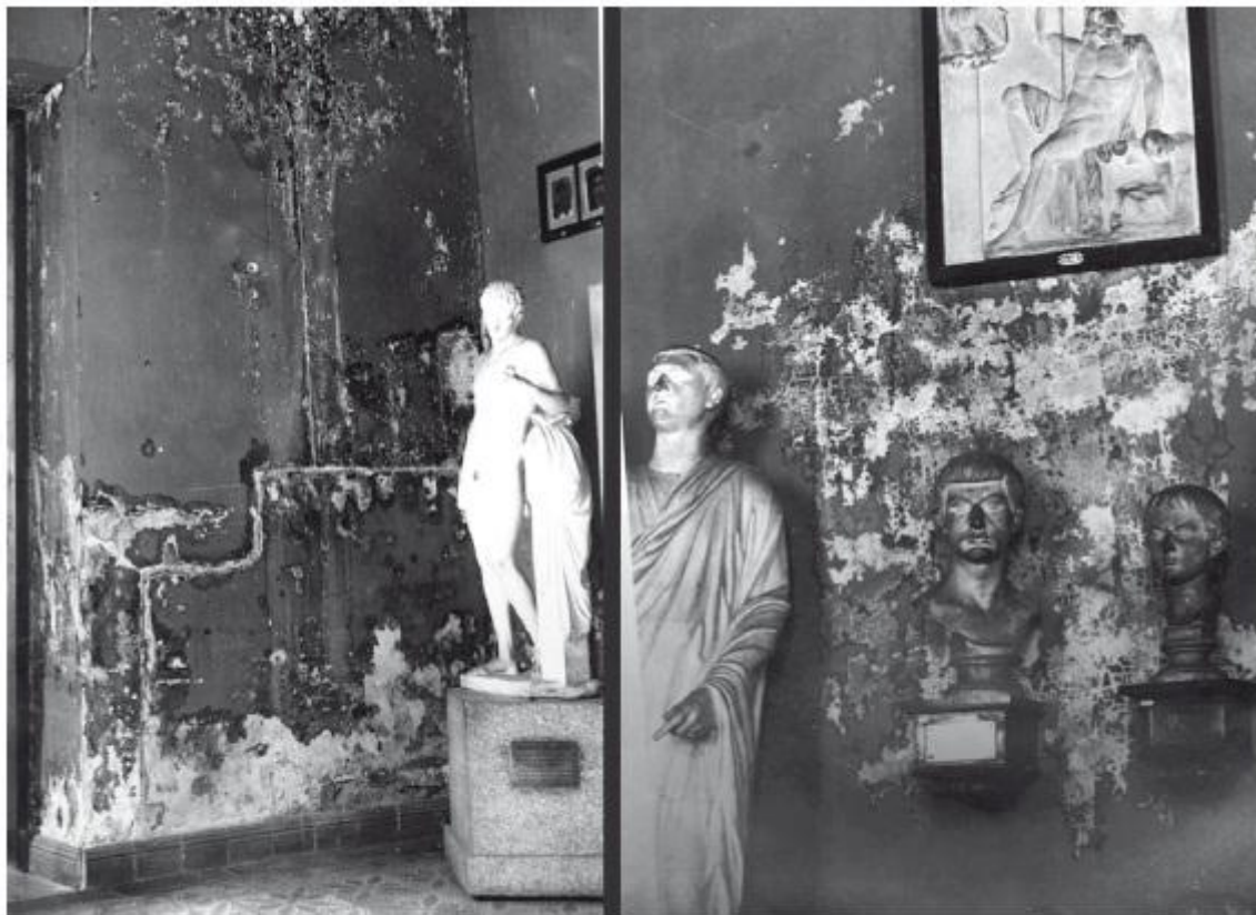
Figura 3. Fotografías del informe de Lafuente Ferrari, director del Museo Nacional de Reproducciones Artísticas de España, sobre los daños causados por la humedad en las salas del Casón del Buen Retiro, 1957. Fuente: Bolaños (2013).
