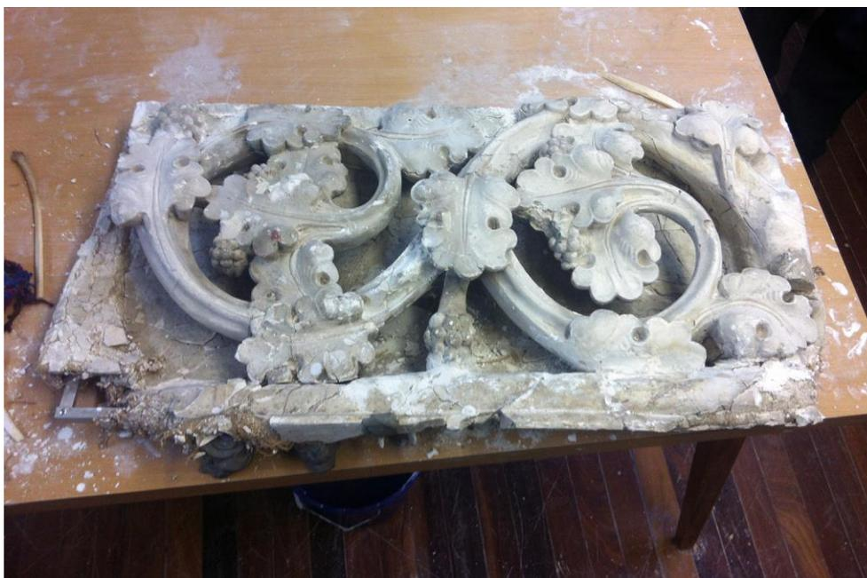
**Figura 1.** Moldura con follaje en estado extremo de deterioro. La pieza había sido «restaurada» con anterioridad, sustituyendo el marco original de madera por uno de aluminio. Foto: E. Hidalgo.
