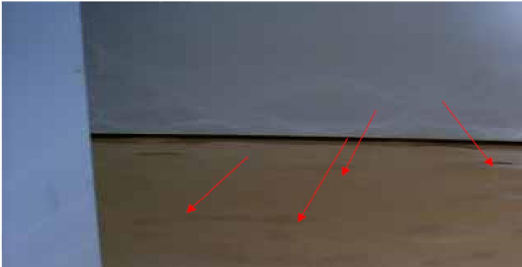
**Figura 7.** Aplicación de recubrimiento sin tratamiento de sustrato\*.
