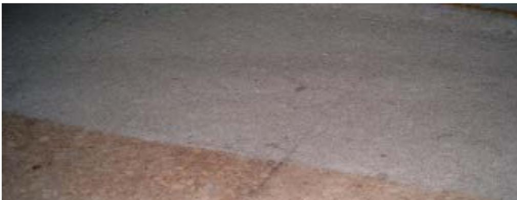
**Figura 5.** Granallado de las losas de terrazo\*.
